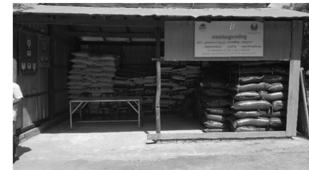
農協には倉庫があるので、泥棒から稲もみ、肥料や農機具の盗難を防ぐことも重要な役割です。
