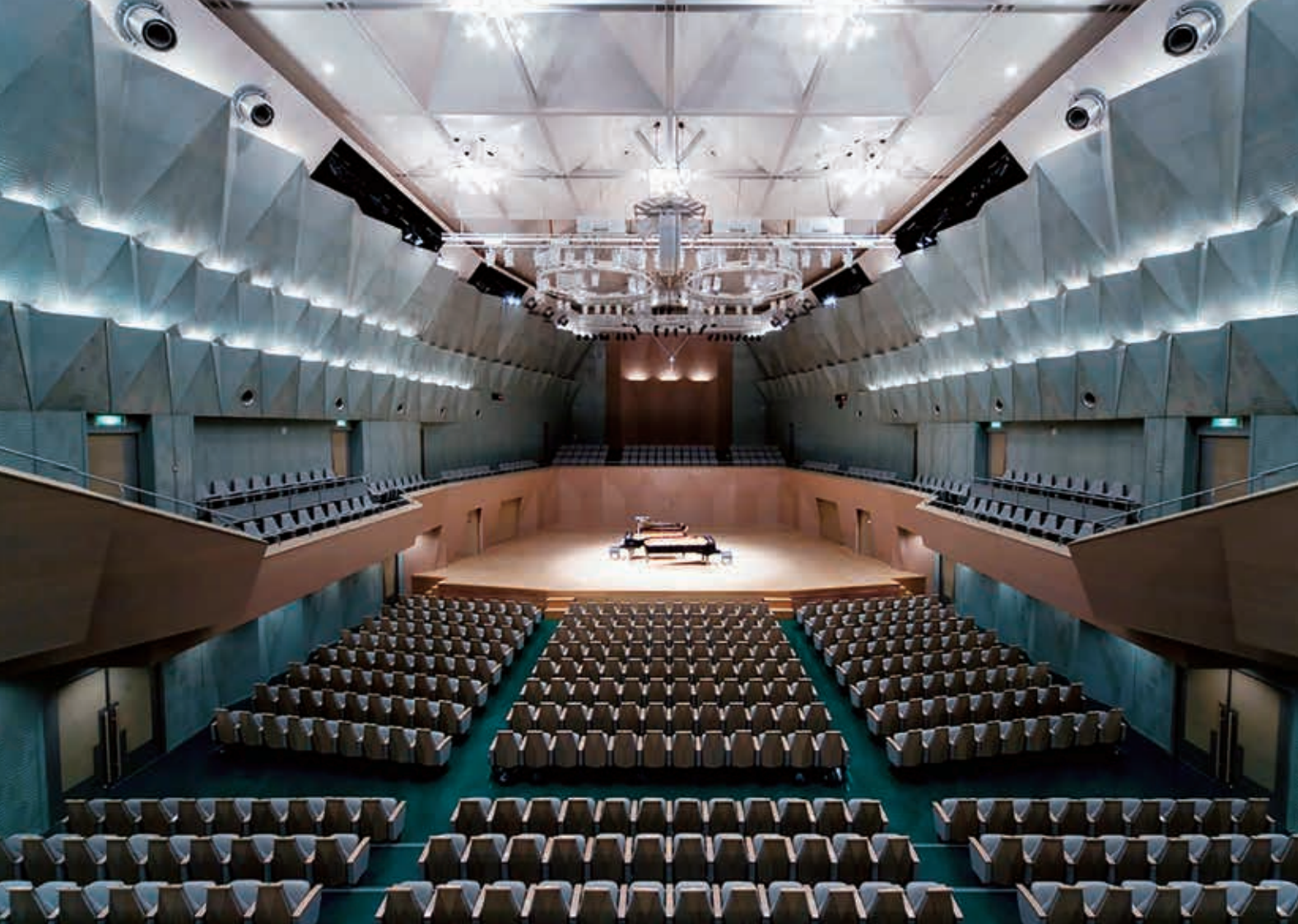
音楽ホール/ICチップをデザインした側壁と天井に反射して、ホール全体に音が降り注ぎます。
